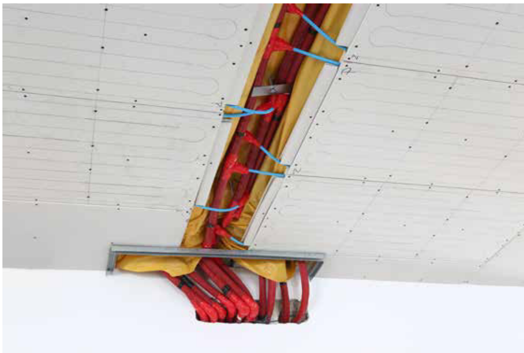
Slika 6. Vgradnja stropnega hlajenja z uporabo ogrevalnih in hladilnih plošč sistema KAN-therm Wall.
