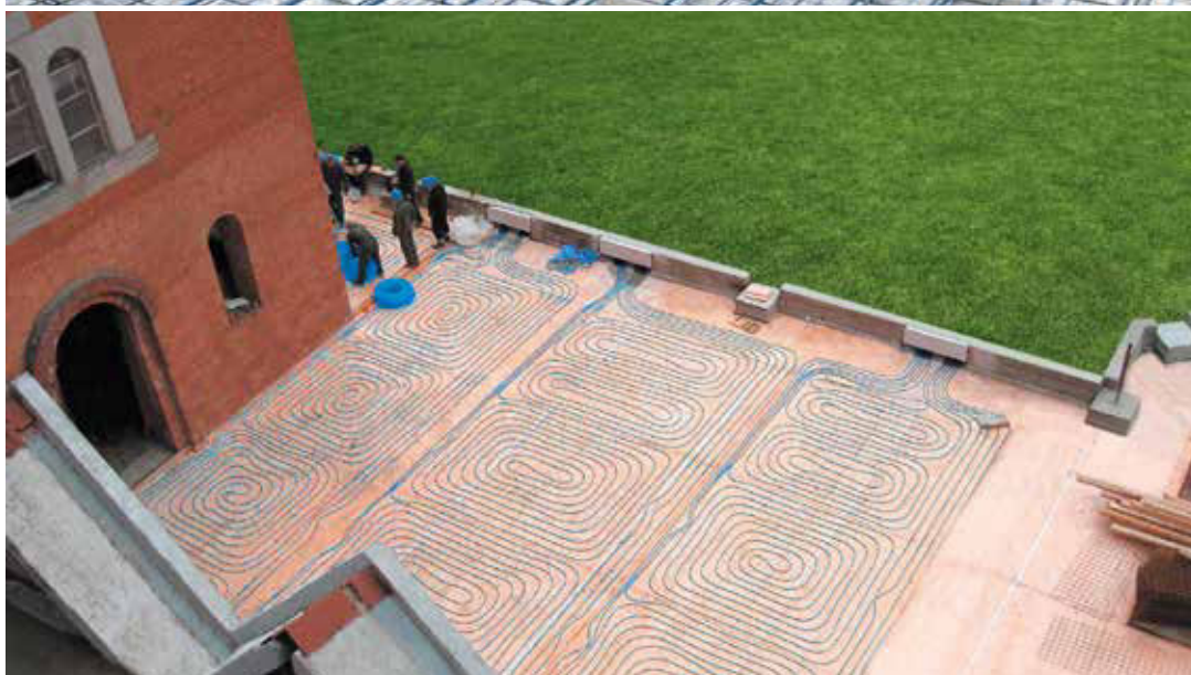
Slika 5. Vgradnja ogrevanja zunanje terase s sistemom KAN-therm s cevmi blueFLOOR PERT.
