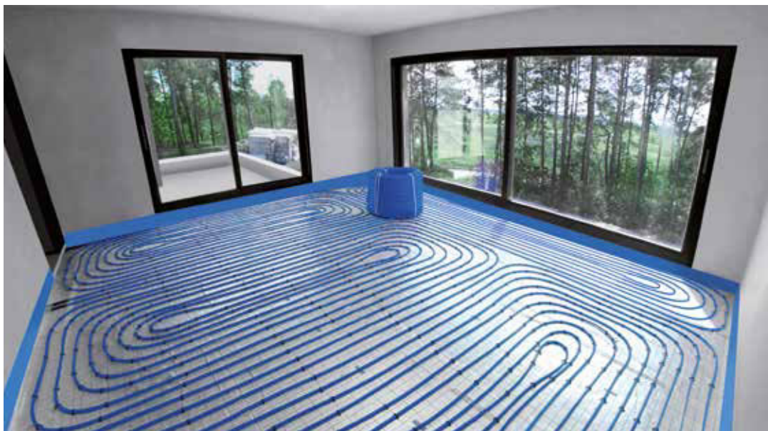
Slika 3. Vgradnja talnega ogrevanja v enojni družinski hiši z uporabo cevi blueFLOOR PERT in sistema KAN-therm Tacker.
