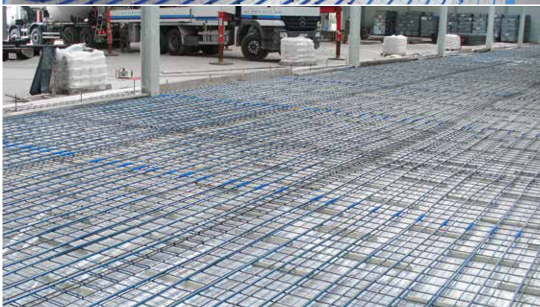
Slika 4. Vgradnja talnega ogrevanja v industrijskem objektu z uporabo cevi blueFLOOR PERT in sistema KAN-therm NET.
