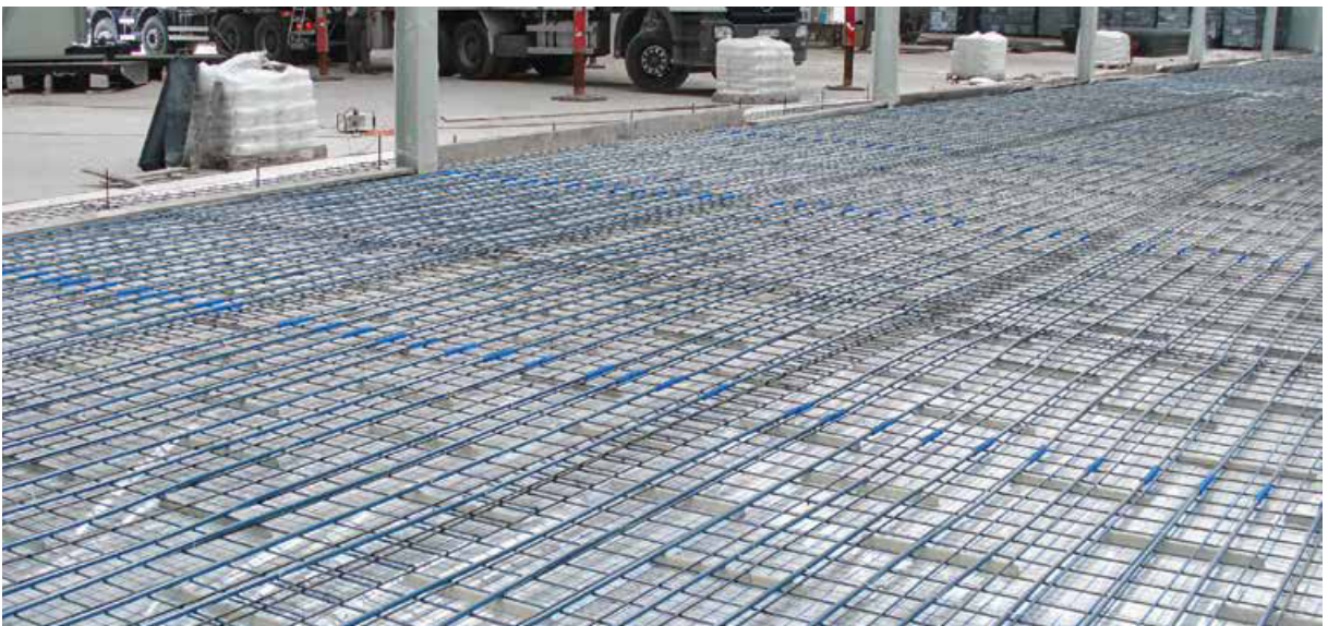
Slika 4. Vgradnja talnega ogrevanja v industrijskem objektu z uporabo cevi bluePERT in sistema KAN-therm NET.
