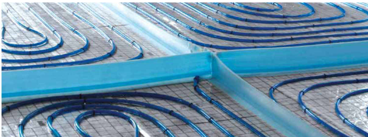
Slika 14. Porazdelitev dilatacijske vrzeli ogrevalnih področij
