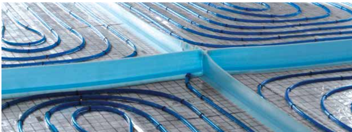
Slika 14. Porazdelitev dilatacijske vrzeli ogrevalnih področij
