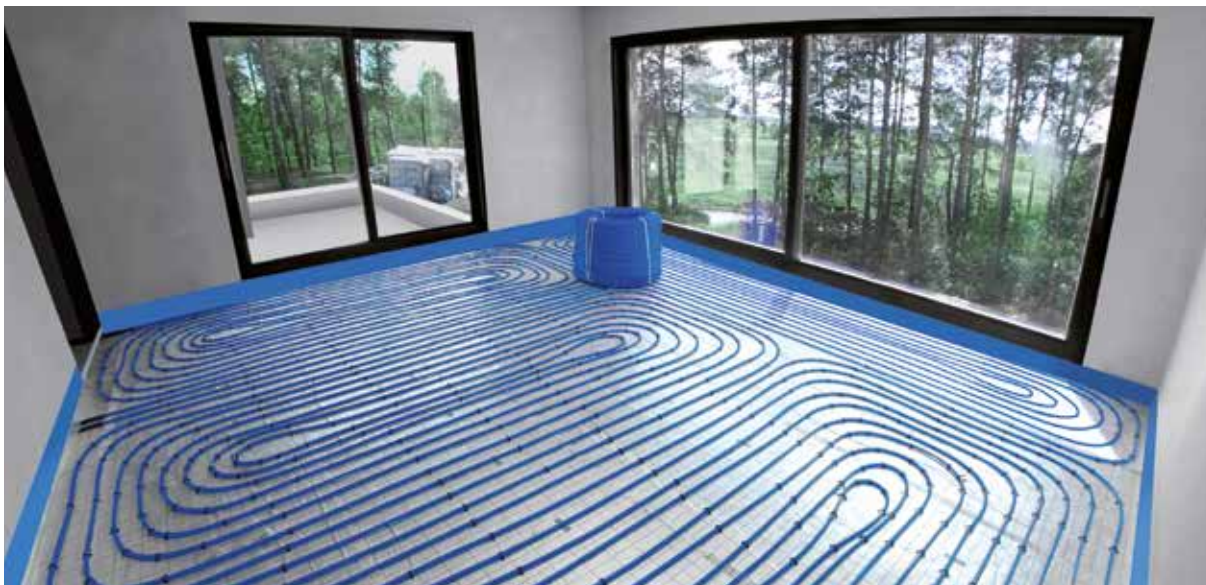
Slika 3. Vgradnja talnega ogrevanja v enostanovanjski družinski hiši z uporabo cevi bluePERT in sistema KAN-therm Tacker.
