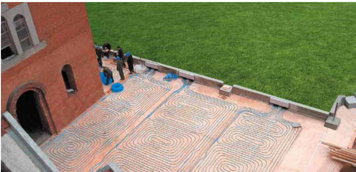
Slika 5. Vgradnja ogrevanja zunanje terase s sistemom KAN-therm s cevmi bluePERT.
