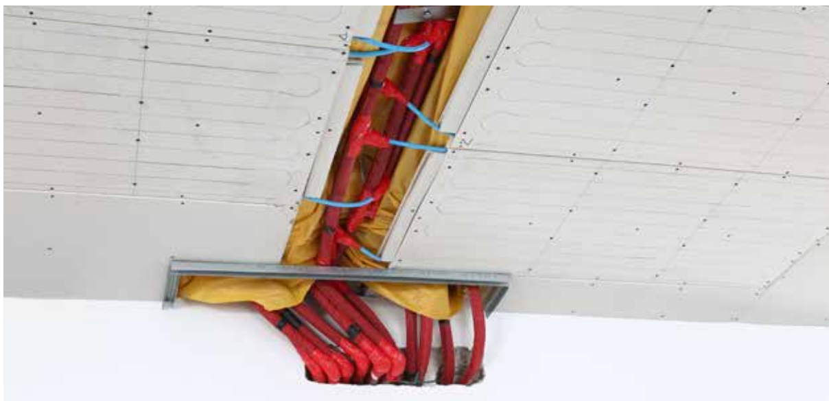
Slika 6. Vgradnja stropnega hlajenja z uporabo ogrevalnih in hladilnih plošč sistema KAN-therm Wall.
