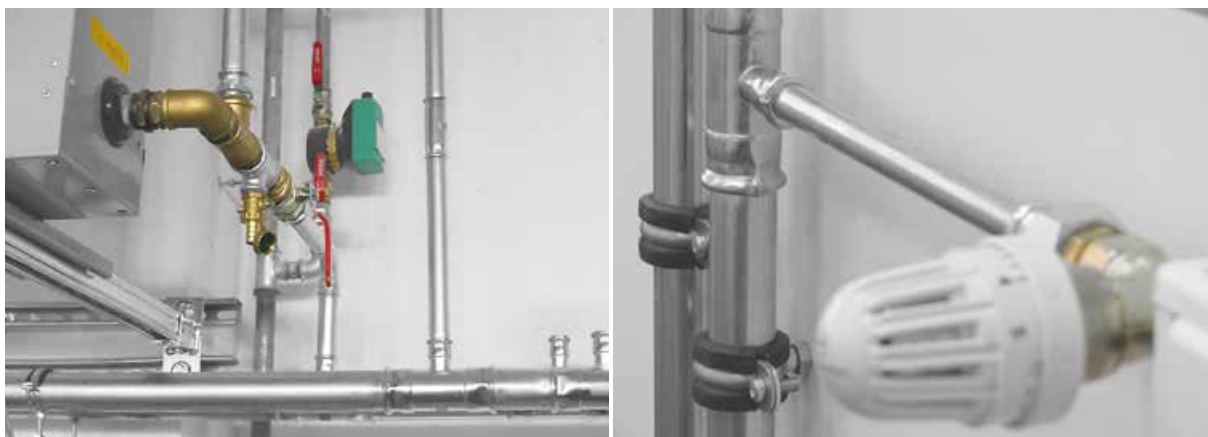
Primeri inštalacij KAN-therm Steel
